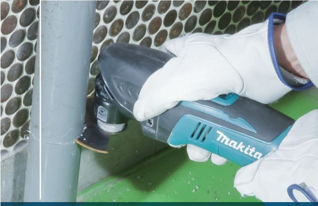
PVC ve FRP boruların kesimi
