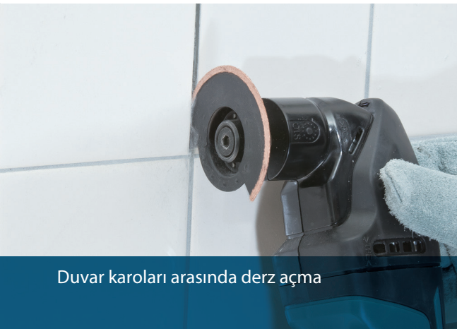
Harç, karo yapıştırıcısı çıkartma
