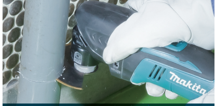
PVC, FRP boru kesimi
