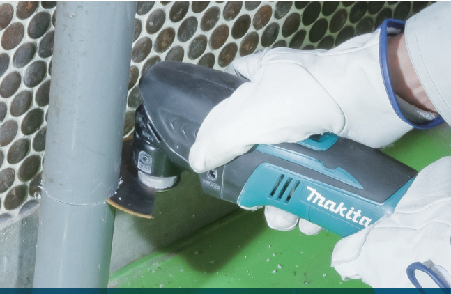
PVC ve FRP boruların kesimi
