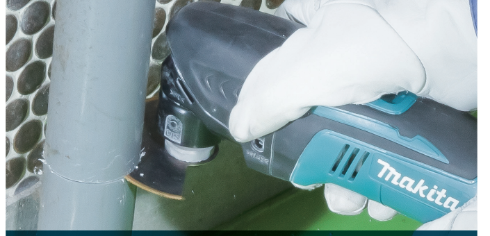
PVC, FRP boru kesimi
